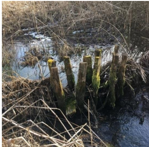
Figure 7 - Photographie d'un des seuils-bouchons partiellement fonctionnel de la mare n°3 (FDCJ)
